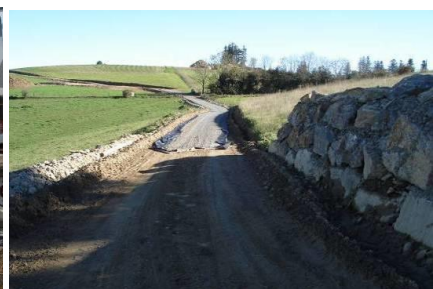
Mise en place du gravier
