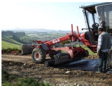
Pose du géotextile
